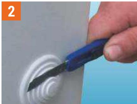
Шаг 2. На нижней панели ножом срезать силиконовый сальник на диаметр, который соответствует диаметру провода ППС.
