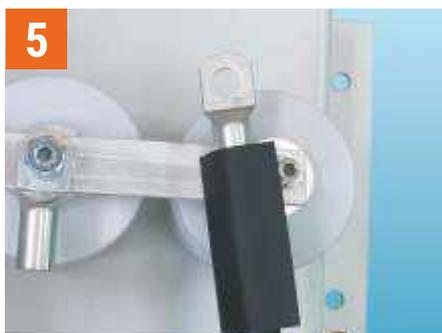
Шаг 5. Надеть наконечник на шпильку ОПН и закрепить гайкой, после чего подвергнуть трубку термоусадке термопистолетом или газовой горелкой.
