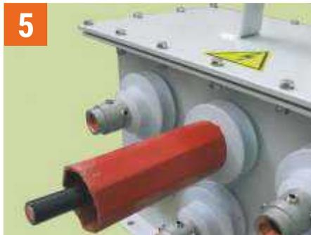
Шаг 5. Надвинуть термоусаживаемую трубку «термофит» на юбку проходного изолятора до упора.
