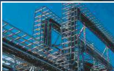
Металлоконструкции для прокладки кабеля
